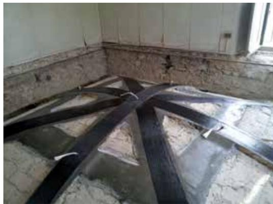
Rinforzo volte in muratura con fibra di carbonio C-Sheet e connettori GFIX in vetro
