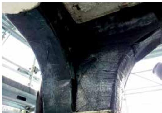
Rinforzo volte in muratura con fibra di carbonio C-Sheet e connettori GFIX in vetro e SFIX in acciaio
