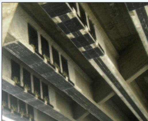
1. Il rinforzo al taglio con fasce di tessuto in carbonio ad alto modulo C-Sheet 390/300/50 presso il viadotto Montefeltro sulla A14
