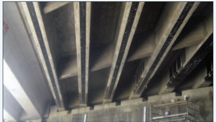
3. Il rinforzo a flessione con lamelle in carbonio CFK 150/2000/1012 sul viadotto Montefeltro
