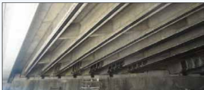
5. Una vista d'insieme dei rinforzi a flessione e taglio sul viadotto Montefeltrino
