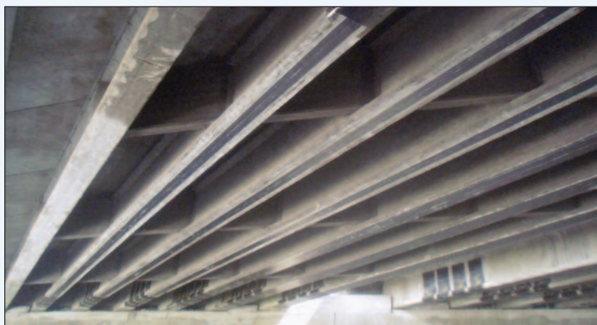
2. Il rinforzo a flessione con lamelle in carbonio CFK 150/2000/1012 sul viadotto della S.S. 3 "Via Flaminia"
