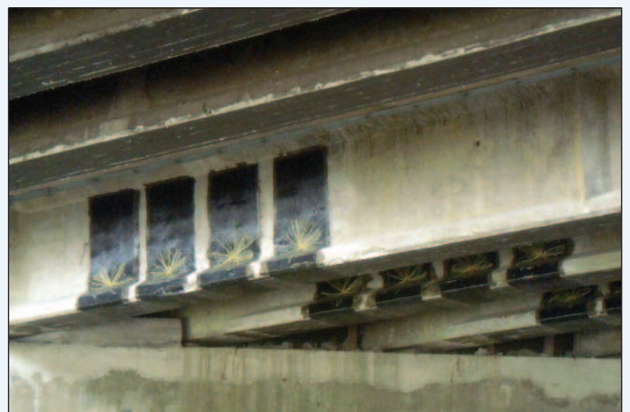
4. Un dettaglio dei connettori in fibra aramidica Afix 10 sul viadotto della S.S. 3 "Via Flaminia"
