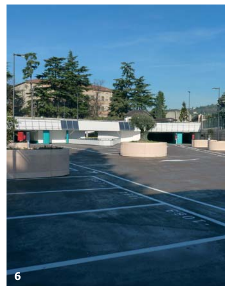
6. Ancora un dettaglio dell'usura "impermeabilizzata", leggera e insieme di elevata portanza e durabilità
