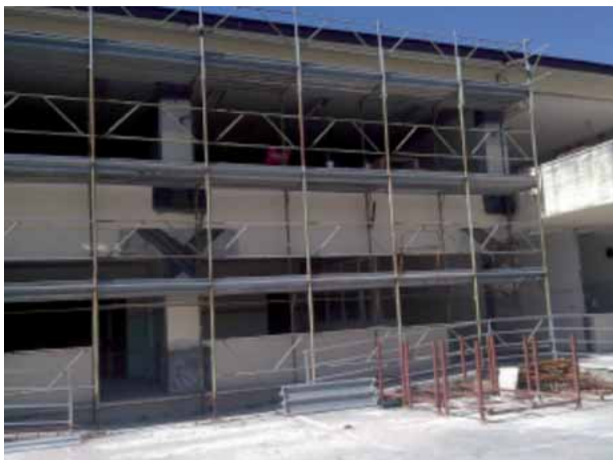
Rinforzo dei nodi trave-pilastro con fasciature in carbonio CFRP e acciaio Steel Net SRP
