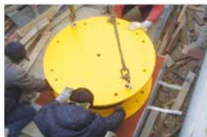
**DISSIPATORI FLUODINAMICI HIFLUID VDD:** hanno la funzione principale di dissipare energia indotta dal sisma, ridurre le vibrazioni e gli effetti del vento o di altre azioni dinamiche. Sono disponibili i dissipatori viscosi con capacità di ricentraggio. Principali impieghi: edifici e strutture civili ed industriali in aree sismiche, ponti stradali e ferroviari. Conformi alla EN 15129 Cap. 7. I materiali sono conformi alla EN 10025 e EN 10088.
