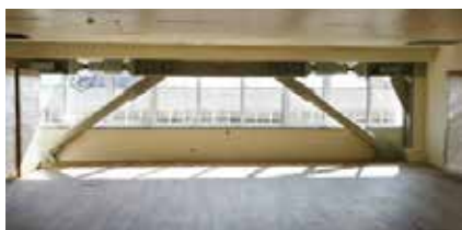
Aplicación particular del refuerzo disipativo y posicionamiento de los disipadores.
