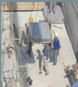
Posicionamiento del aislador
