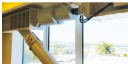
Aplicación particular del refuerzo disipativo y posicionamiento de los disipadores.
