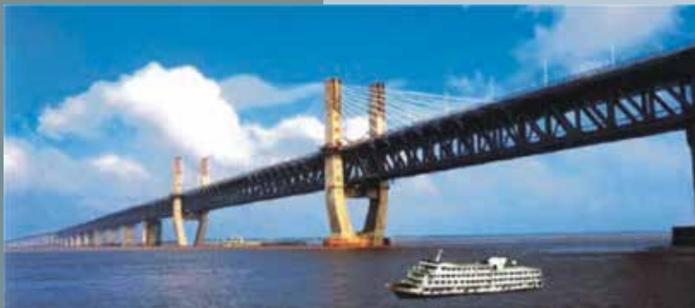
Puente de carretera y ferroviario Wuhu Yangtze River Bridge (China)
