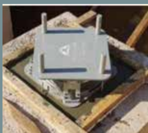
Posicionamiento del aislador
