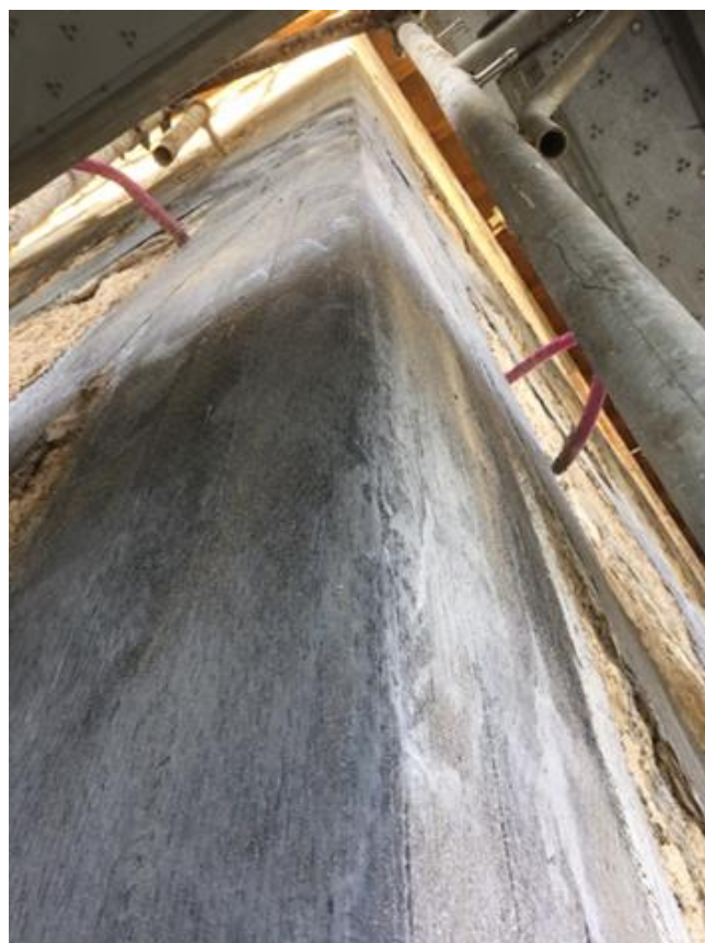
Figura 9. Particolare del rinforzo sullo spigolo esterno.
