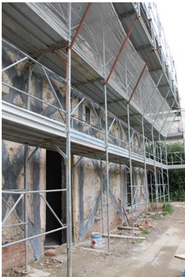
Figura 6. Scorcio della parete esterna rinforzata.
