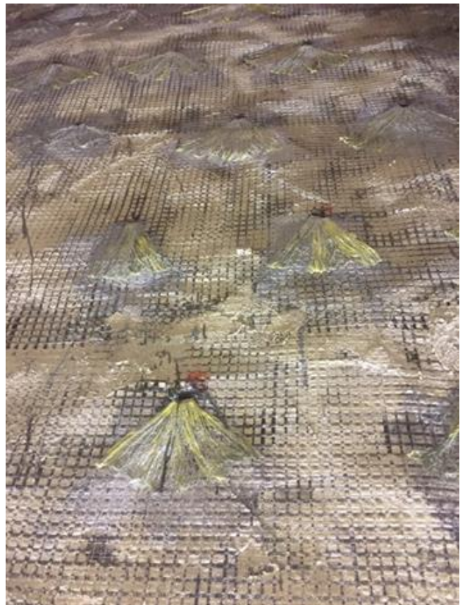
Figura 12. Dettaglio dei connettori.
