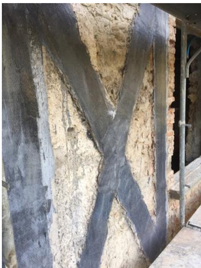
Figura 7. Dettaglio di una Croce di Sant'Andrea.
