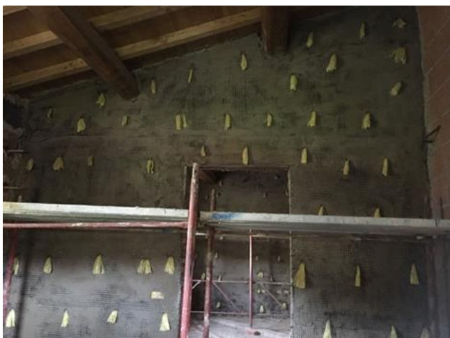
Figura 10. Vista di una parete interna.
