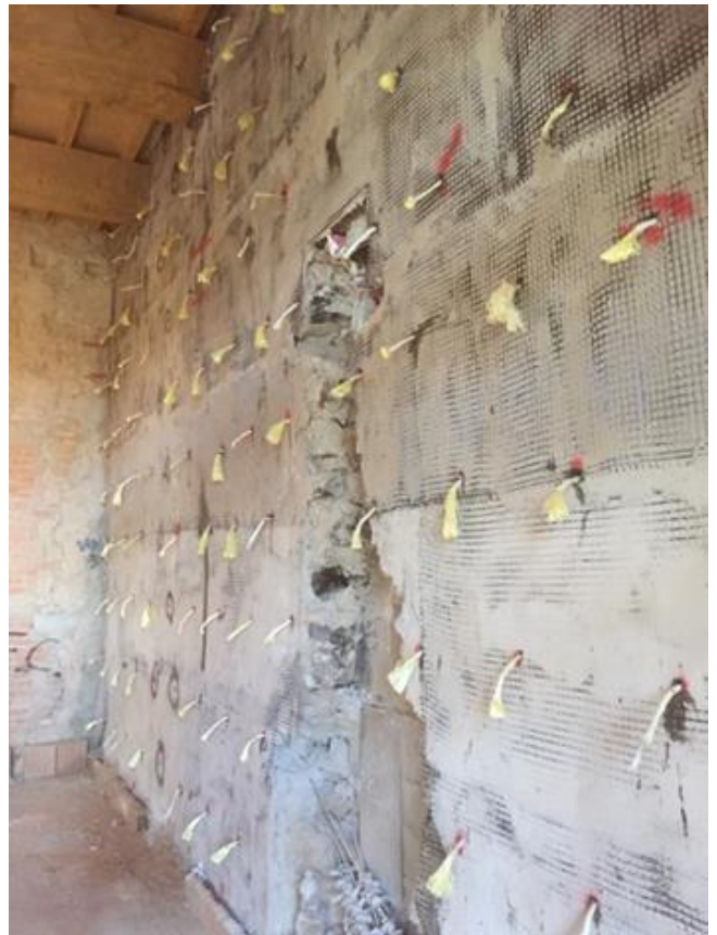
Figura 11. Dettaglio del rinforzo FRCM.
