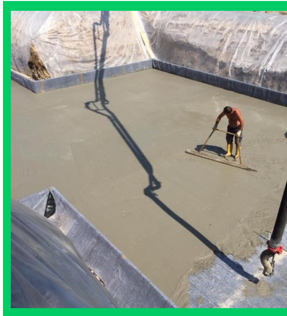
Dettagli costruttivi e operatività di cantiere
