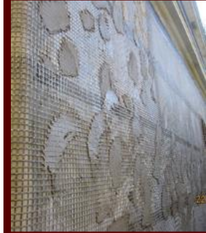
Interventi di rinforzo della muratura
