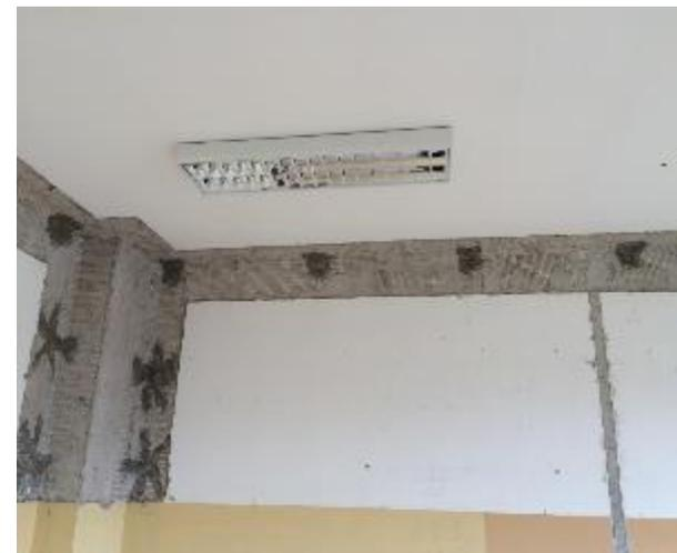
Il Sistema STG (Strong Tie Glass) è una soluzione particolarmente idonea per antiribalta a basso spessore nel rinforzo locale di elementi strutturali secondari e non strutturali quali tramezzature, tamponamenti, collegamenti perimetrali.
