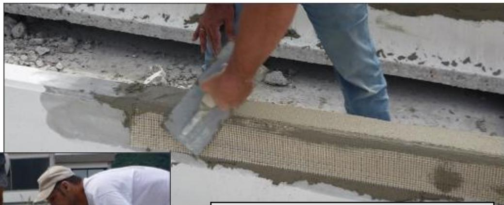
TT04 – Rinforzo con tessuto in acciaio STEEL NET G220 e malta CONCRETE ROCK V2
