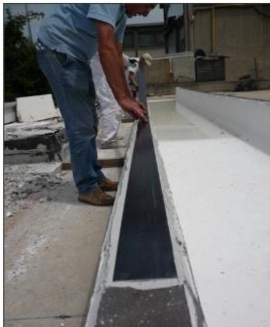
TT02 - Rinforzo con lamella CFK in carbonio e adesivo RESIN 90
