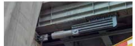
**APPOGGI SFERICI** HIFLOW: consentono la rotazione attorno ai tre assi e possono trasmettere il carico in ogni direzione senza spostamenti (tipo FS), oppure permettere lo spostamento in una direzione (tipo GS), oppure permettere lo spostamento nelle direzioni del piano (tipo SS). Conformi alla norma EN 1337.7. Principali impieghi: edifici e strutture civili ed industriali in aree sismiche, ponti stradali e ferroviari. Hanno una durabilità superiore ai 100 anni con manutenzioni minime.
