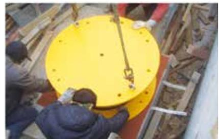
**DISSIPATORI FLUODINAMICI** HIFLUID VDD-VSD: hanno la funzione principale di dissipare energia indotta dal sisma, ridurre le vibrazioni e gli effetti del vento o di altre azioni dinamiche. Sono disponibili i dissipatori viscosi con capacità di ricentraggio. Principali impieghi: edifici e strutture civili ed industriali in aree sismiche, ponti stradali e ferroviari. Conformi alla EN 15129 Cap. 7. I materiali sono conformi alla EN 10025 e EN 10088.
