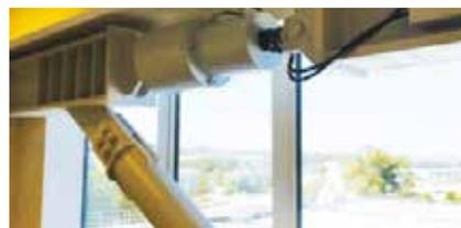
Particolare dell'applicazione dei controventi dissipativi e posizionamento dei dissipatori
