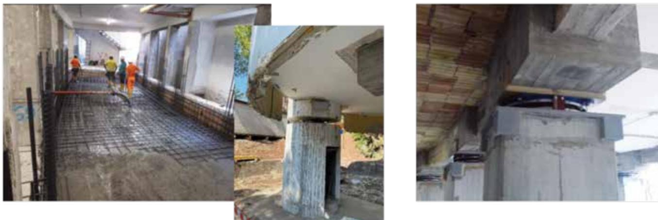
Figura 2: a. Realizzazione platea di fondazione e ringrosso pilastri e travi rovesce; b. isolatore in sommità al vano scale; c. isolatore in sommità al pilastro ringrossato
