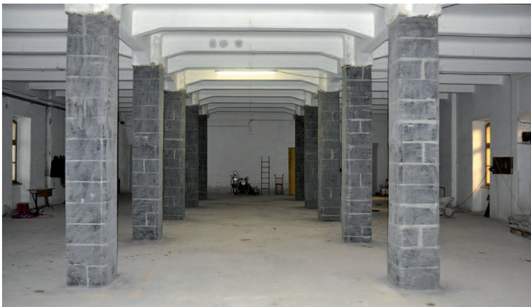
Figura 14 Sistema di rinforzo dei pilastri completato.
