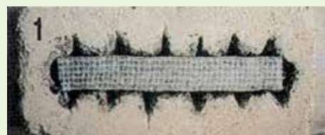
SUPERSTOP posizionato nel calcestruzzo
