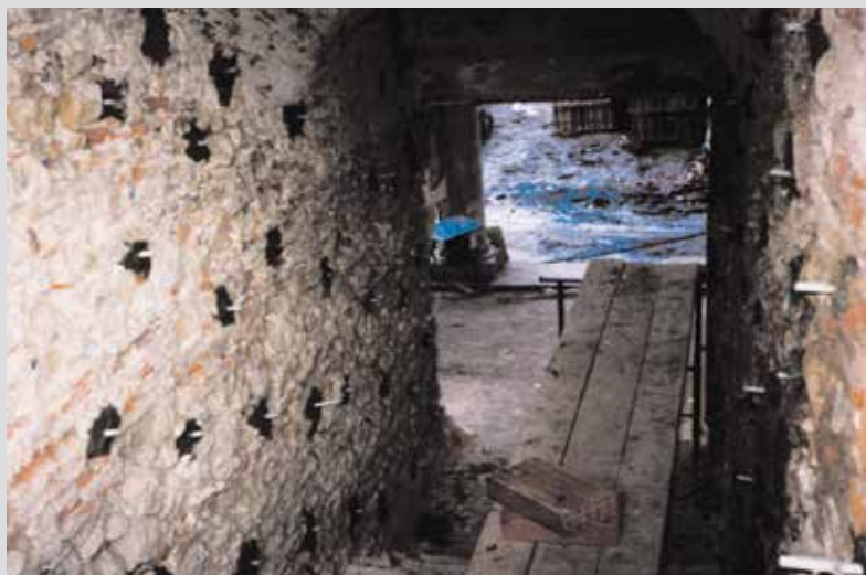
Iniezioni di boiacche in calce idraulica in murature antiche.
