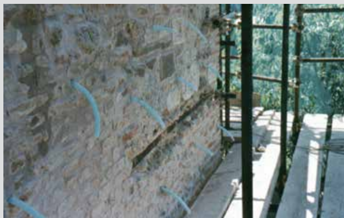
Iniezioni di boiacche in calce idraulica in murature antiche.
