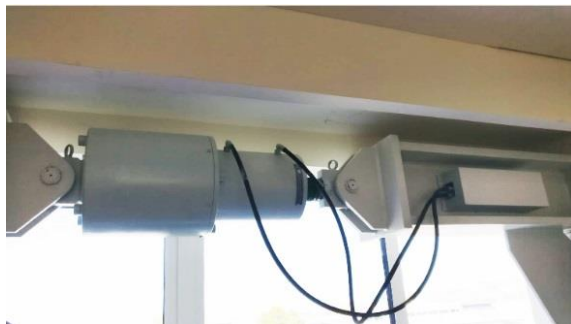
Figura 8. Particolare attacco telaio-controvento di un HIFLUID VSD
