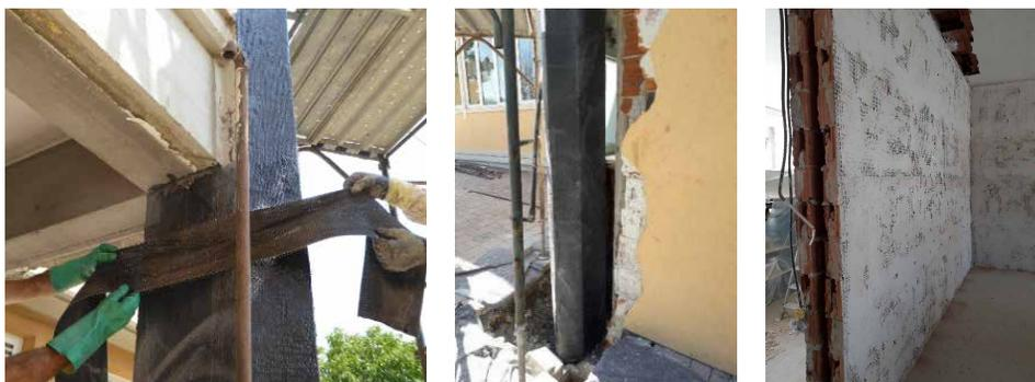
Mediante la medesima tecnica FRCM è stato possibile rinforzare le tamponature in modo da scongiurare il pericolo dell'antiribalta fuori piano tipico di paramenti scarsamente ancorati agli elementi strutturali adiacenti. Nella parte superiore e inferiore sono stati quindi previsti connettori a fiocco GFIX 10 inghisati alle travi di fondazioni e ai cordoli di piano in modo tale da rendere il sistema collaborante con la struttura in c.a.
