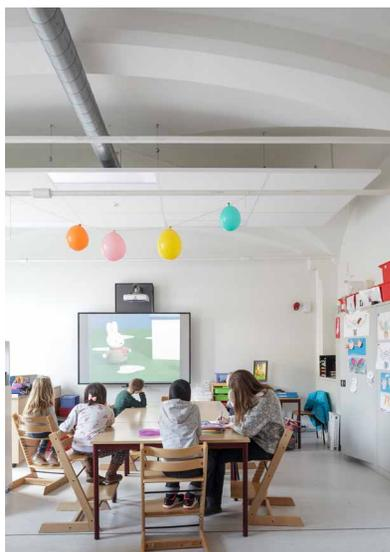
L'esigenza di eseguire una correzione acustica non invasiva, che si integrasse con la struttura esistente e che esaltasse la bellezza degli antichi soffitti voltati, ha portato alla realizzazione di elementi sospesi leggeri.
