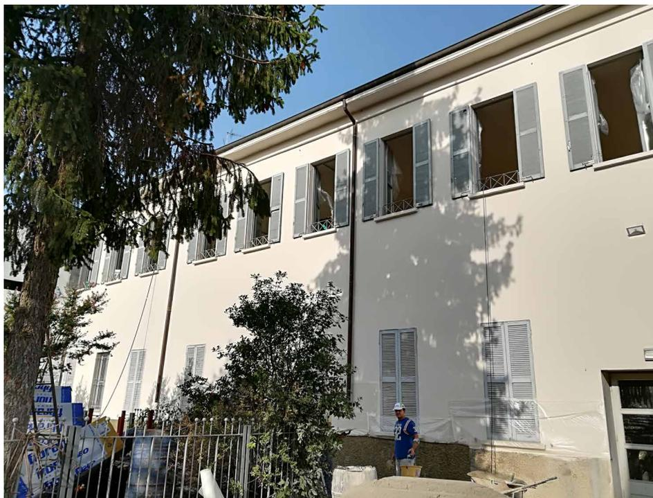
L'edificio oggetto di intervento è costituito da più corpi di fabbrica pluripiano costituiti da una struttura portante in muratura e solai in laterocemento caratterizzati da traliccio tipo SAP parzialmente prefabbricato e completato da un getto di c.a. in opera. L'intervento, oltre ai solai, ha riguardato interventi sui maschi portanti al fine di migliorare il comportamento globale dell'edificio.
