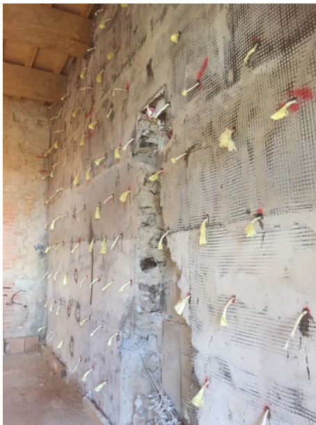
Figura 7 - Dettaglio del rinforzo FRCM
