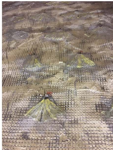
Figura 8 - Dettaglio dei connettori
