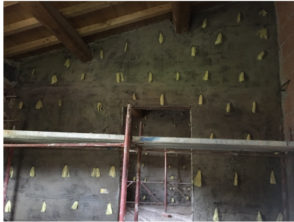
Figura 6 - Vista di una parete interna
