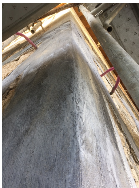
Figura 5 - Particolare del rinforzo sullo spigolo esterno
