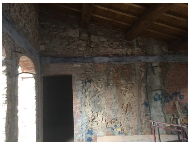
Figura 4 - Vista di una catena interna
