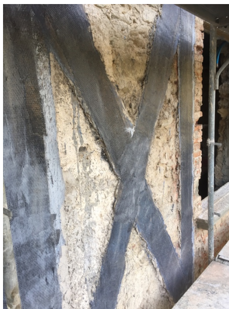
Figura 3 - Dettaglio di una Croce di Sant'Andrea
