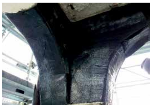
Rinforzo volte in muratura con fibra di carbonio C-Sheet e connettori GFIX in vetro e SFIX in acciaio Civita di Bagno (Aq) - Edificio privato
