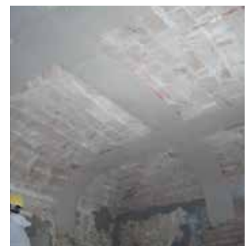
Cantiere aggregato di Via Roma all'Aquila Rinforzo di murature e volte con tessuto in fibra di acciaio galvanizzato STEEL NET G 220, malta a base calce LIMECRETE e connettori in acciaio SFIX G.
