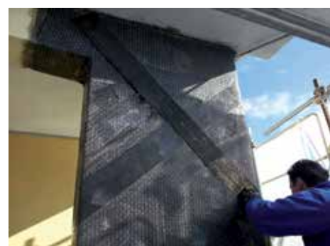
Rinforzo nodi c.a. con fibra di carbonio C-Sheet Monticchio (Aq) - Edificio privato
