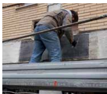
Rinforzo nodi e pilastri c.a. con fibra di carbonio bidirezionale CTB e quadriassiale C-Sheet L'Aquila - Condomini
