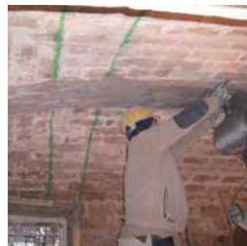
Cantiere aggregato di Via Roma all'Aquila Rinforzo di murature e volte con tessuto in fibra di acciaio galvanizzato STEEL NET G 220, malta a base calce LIMECRETE e connettori in acciaio SFIX G.
