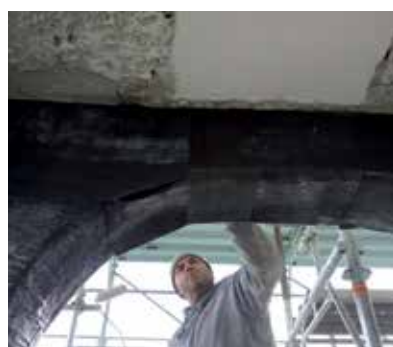
Rinforzo volte in muratura con fibra di carbonio C-Sheet e connettori GFIX in vetro e SFIX in acciaio Civita di Bagno (Aq) - Edificio privato
