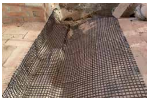
Cantiere Palazzo Chiarino (AQ) Rinforzo di volte con rete in carbonio C-NET, connettore CFIX e malta in calce naturale LIMECRETE.
