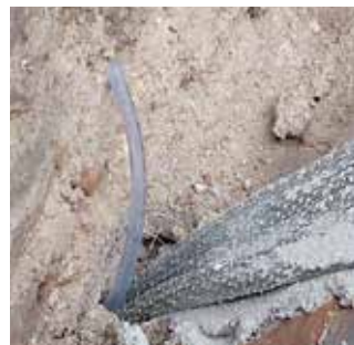
Cantiere aggregato di Via Roma all'Aquila Rinforzo di murature e volte con tessuto in fibra di acciaio galvanizzato STEEL NET G 220, malta a base calce LIMECRETE e connettori in acciaio SFIX G.
