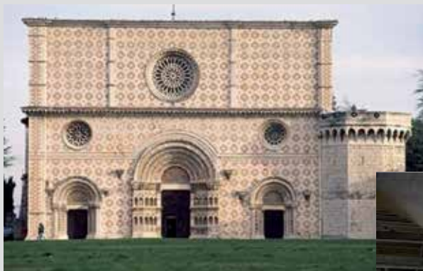
Recupero strutturale Basilica S. Maria in Collemaggio L'Aquila.
