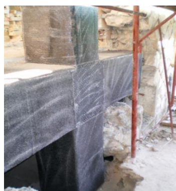
Immagine 4: Rinforzo nodi trave – colonna con CFRP.
