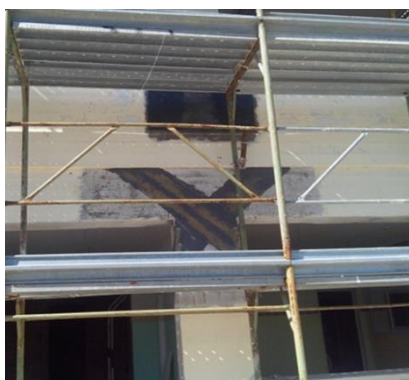
Immagine 4: Rinforzo nodi trave – colonna con CFRP.
