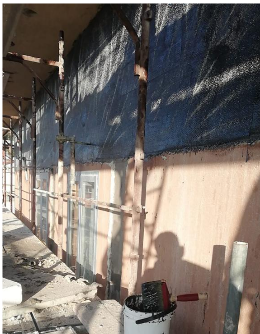
Immagine 7: Rinforzi fasce di piano con CFRP.
