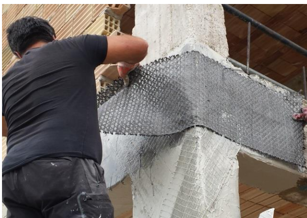
Immagine 5: Rinforzo nodi d'angolo con CFRP.
