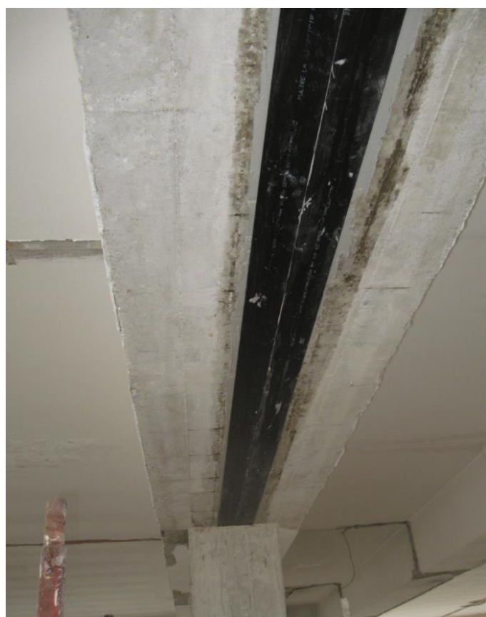
Immagine 1: Rinforzi strutturali con sistema FRP.
