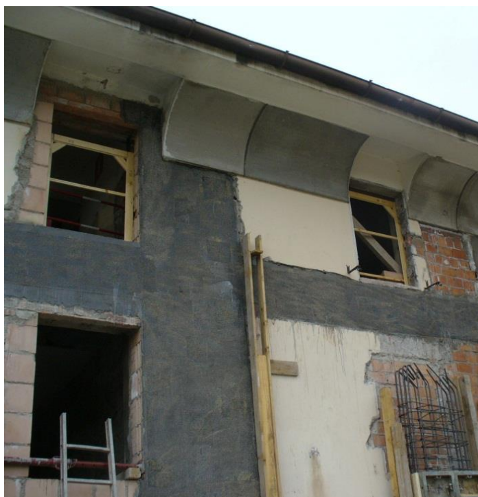
Immagine 15: Fasciatura di piano con CFRP.
