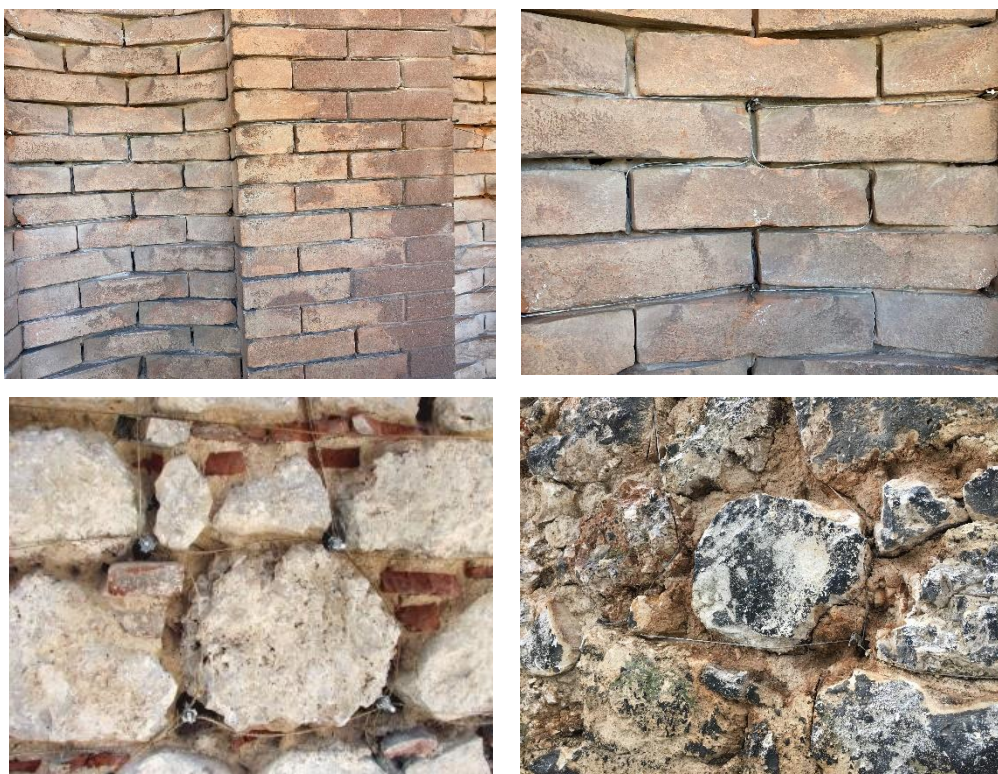
Immagine 20: Sistema ANCHORSTEEL NET su laterizio regolare e pietrame squadrato.
