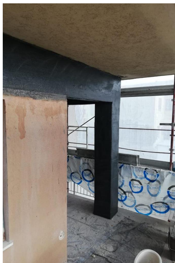
Immagine 1: Rinforzi strutturali con sistema FRP.
