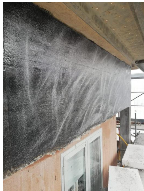
Immagine 7: Rinforzi fasce di piano con CFRP.
