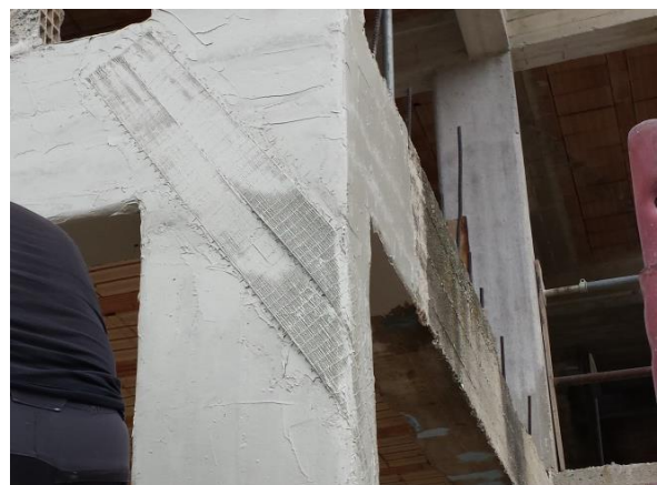
Immagine 5: Rinforzo nodi d'angolo con CFRP.
