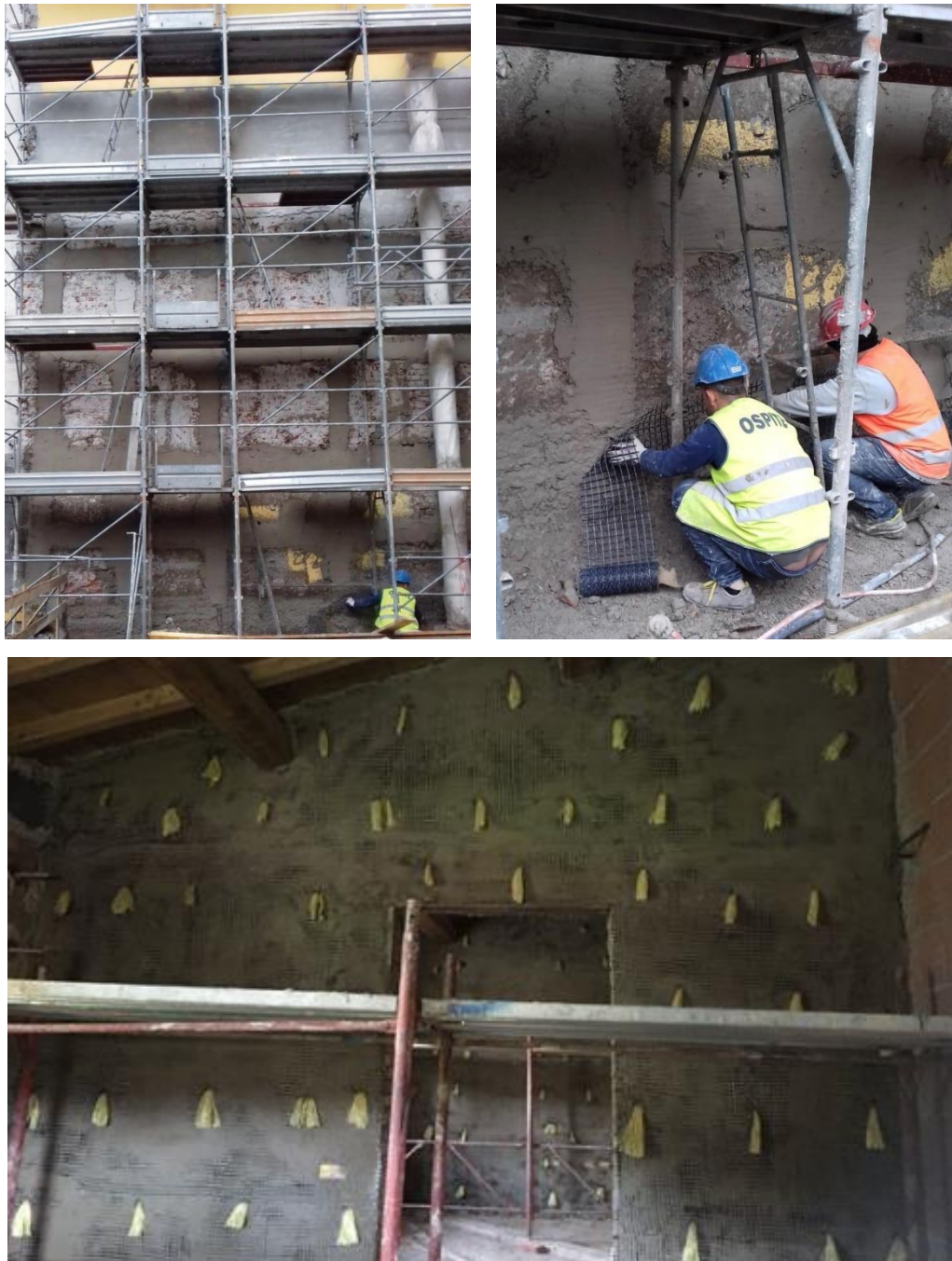
Immagine 2: Rinforzi strutturali con sistema FRCM.
