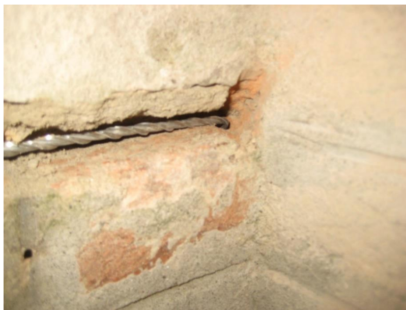
Immagine 22: Ristilatura armata (SAC).
