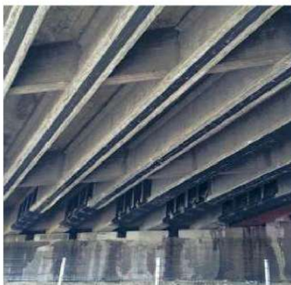
IL RINFORZO DI VIADOTTI E SOTTOVIE DELLA A14
