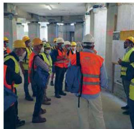
IL TEAM DI G&P PRESSO VILLA SERENA A JESI ISOLATA SISMICAMENTE
