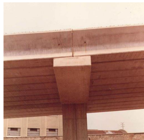
▲ Dettaglio del punto di incontro delle travi di bordo
