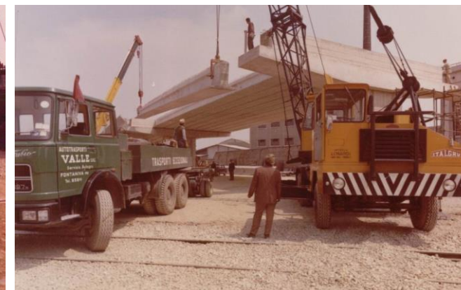
▲ Posizionamento trave centrale impalcato
