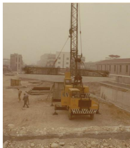
▲ Movimentazione elementi strutturali
