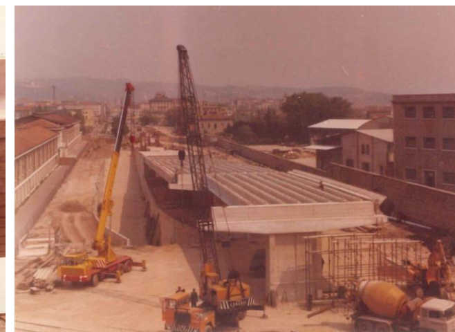
▲ Immagine aerea del cantiere
