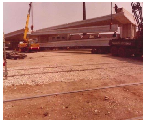
▲ Sollevamento trave centrale impalcato
