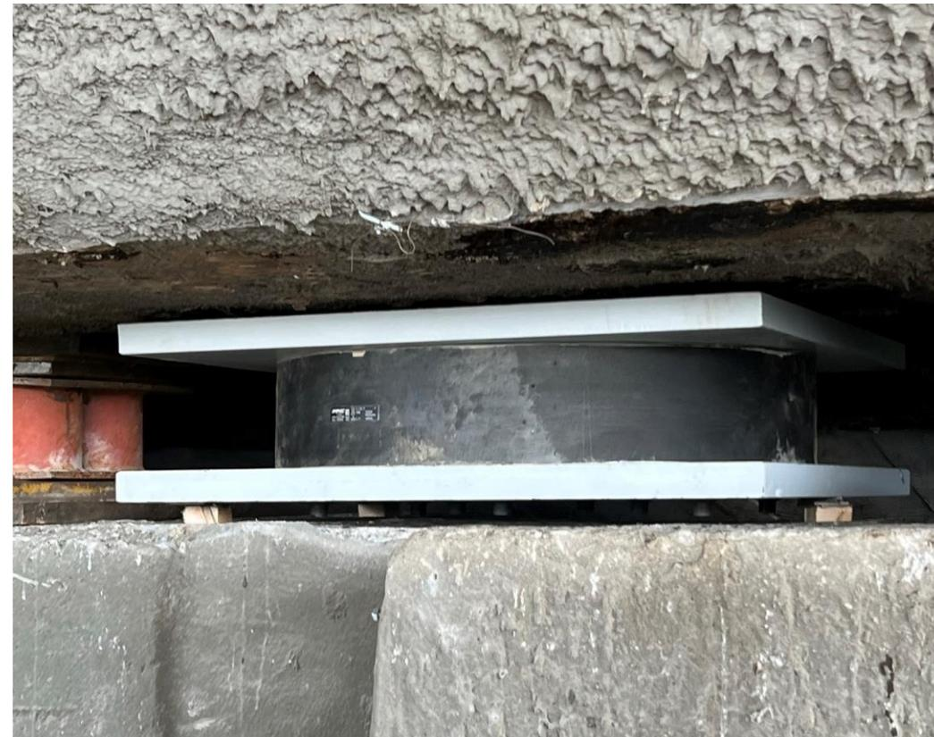
*Appoggi su pila - operazioni di sostituzione degli appoggi su pila 3*
