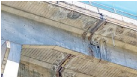
Degrado delle selle Gerber, esposizione agli agenti atmosferici: ristagno d'acqua, aggressione da cloruri ecc..
