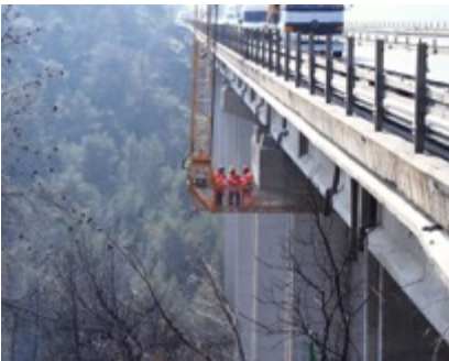
Piattaforma by-bridge per l'accesso dall'impalcato
