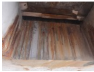
Degrado delle selle Gerber, esposizione agli agenti atmosferici: ristagno d'acqua, aggressione da cloruri ecc..
