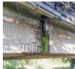
Degrado delle selle Gerber, esposizione agli agenti atmosferici: ristagno d'acqua, aggressione da cloruri ecc..
