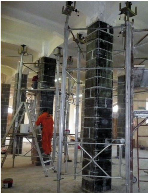
Rinforzo con FRP a confinamento e taglio di pilastri in c.a.
