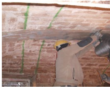
Rinforzo di volte con sistema FRCM reti in carbonio, vetro AR, tessuti in acciaio
