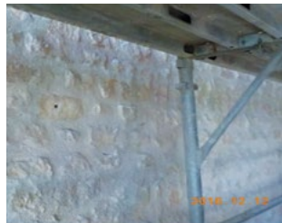
Rinforzo paramenti faccia a vista con cuciture e stilature armate STEEL ANCHORFIX e sistemi a reticolo con barre elicoidali ANCHORSTEEL NET
