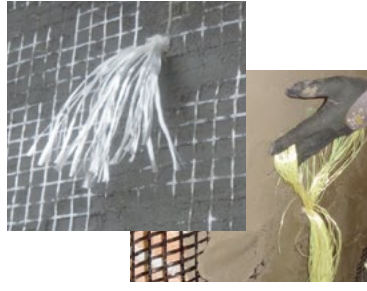
Rinforzo murature con sistemi FRCM e connettori a fiocco
