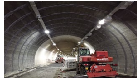
Consolidamento gallerie autostradali lesionate con STEEL NET G
