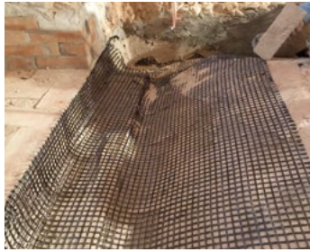
Rinforzo di volte con sistema FRCM reti in carbonio, vetro AR, tessuti in acciaio
