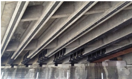
Rinforzo con FRP a flessione e taglio per travi da ponte in c.a. e c.a.p.
