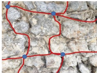
Rinforzo paramenti faccia a vista con cuciture e stilature armate STEEL ANCHORFIX e sistemi a reticolo con barre elicoidali ANCHORSTEEL NET
