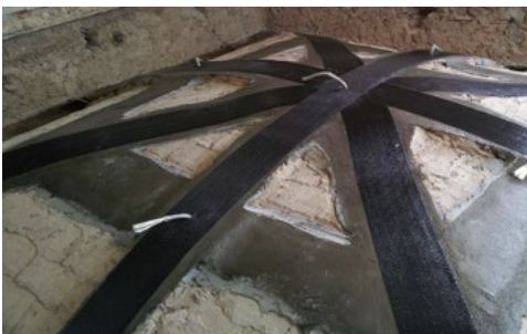
Rinforzo con FRP di volte in muratura
