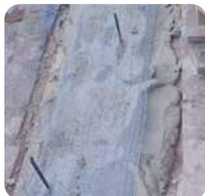
**Sistema FRCM-SRG** per il consolidamento di strutture in muratura **costituito da tessuto unidirezionale in trefoli di acciaio galvanizzato UHTSS** immerso in matrice inorganica a basa calce idraulica naturale M15.
