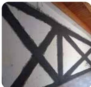
**Sistema FRP** per il consolidamento di strutture in c.a., c.a.p., murature, legno e acciaio, **costituito da tessuto bidirezionale in fibra di carbonio** classe 210C immerso in matrice epossidica bicomponente.
