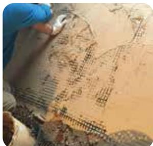
**Sistema FRCM** per il consolidamento di strutture in muratura costituito da rete bidirezionale apprettata in fibra di basalto immersa in matrice inorganica a base calce idraulica naturale M15.
