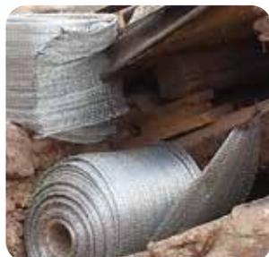
**Sistema SRP** per il consolidamento di strutture in c.a., c.a.p., costituito da **tessuto unidirezionale in trefoli di acciaio galvanizzato UHTSS** immerso in matrice epossidica bicomponente.
