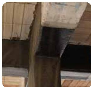
**Sistema FRP** per il consolidamento di strutture c.a., c.a.p., murature, legno e acciaio, **costituito da tessuto unidirezionale in fibra di carbonio** Classe 210C immerso in matrice epossidica bicomponente.
