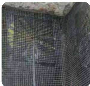
**Sistema FRCM** per il consolidamento di strutture in muratura costituito da **rete bidirezionale in fibra di carbonio** immersa in matrice inorganica monocomponente a reattività pozzolanica R2, compatibile con le murature storiche.
