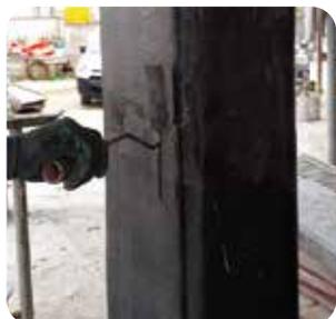
**Sistema FRP** per il consolidamento di strutture in c.a., c.a.p. e acciaio, **costituito da tessuto unidirezionale in fibra di carbonio** alto modulo Classe 350/2800C immerso in matrice epossidica bicomponente.
