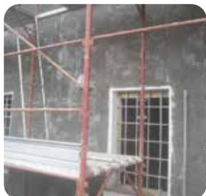
**Sistema FRCM** per il consolidamento di strutture in muratura costituito da rete bidirezionale apprettata in fibra di vetro AR alcali resistente immersa in matrice inorganica a base calce idraulica naturale M15.
