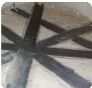
**Sistema FRP** per il consolidamento di strutture in calcestruzzo, murature e legno, **costituito da tessuto unidirezionale e bidirezionale in fibra di basalto** classe 60B immerso in matrice epossidica bicomponente.
