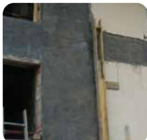
**Sistema FRCM** per il consolidamento di strutture in calcestruzzo costituito da rete bidirezionale in fibra di carbonio immersa in matrice inorganica cementizia bicomponente fibrorinforzata R4.
