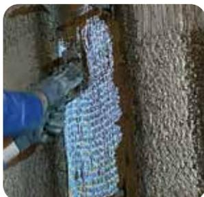
Sistema **FRCM-SRG** per il consolidamento di strutture in calcestruzzo **costituito da tessuto unidirezionale in trefoli di acciaio galvanizzato UHTSS** immerso in matrice inorganica cementizia bicomponente R4.
