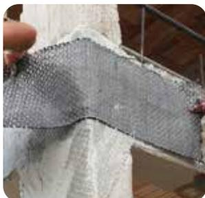
Sistema FRP per il consolidamento di strutture in c.a., c.a.p. e murature, **costituito da tessuto quadriassiale in fibra di carbonio** Classe 210C immerso in matrice epossidica bicomponente.
