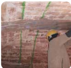
**Sistema FRCM-SRG** per il consolidamento di strutture in muratura **costituito da tessuto unidirezionale in trefoli di acciaio galvanizzato UHTSS** immerso in matrice inorganica a base calce idraulica naturale M15.
