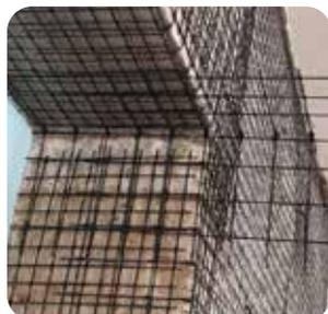
**Sistema CRM** per il consolidamento di strutture in muratura e calcestruzzo **costituito da rete preformata rigida in GFRP** immersa in malte, calcestruzzi e betoncini.
